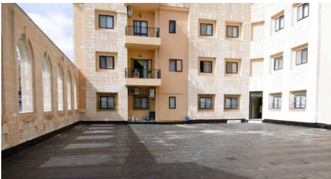
Waterproofing membrane fl-ewwel stadji tax-xogħlijiet f'Pembroke
