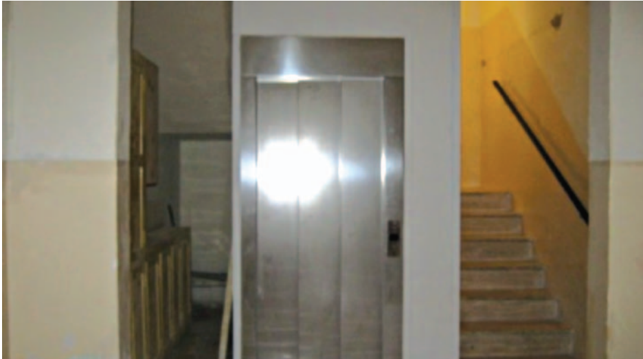
Installazzjoni ta' lifts
